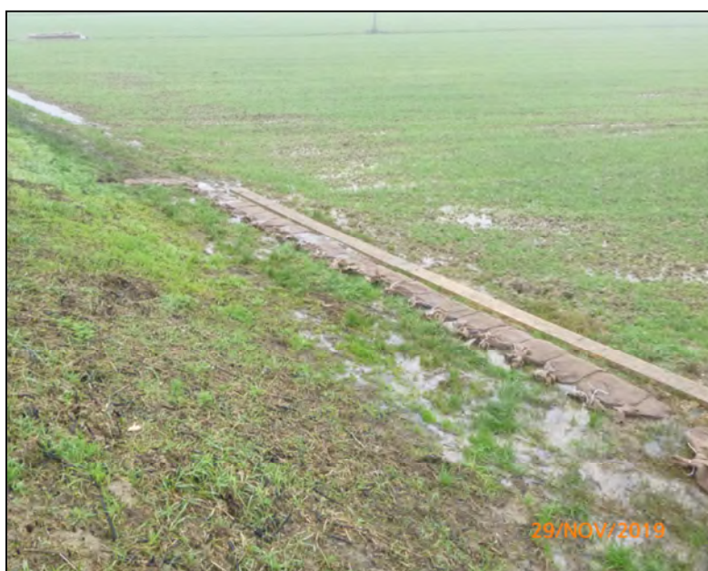
Fig. 10: località Cavanella Po - in evidenza una delle zone di saturazione al piede dell'argine (29.11.2019)
