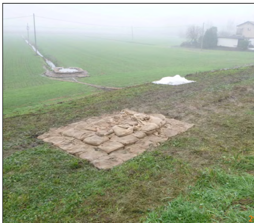
Fig. 11: località Cavanella Po - In evidenza alcune delle zone di cedimento del piè di banca arginale (16.11.2019)
