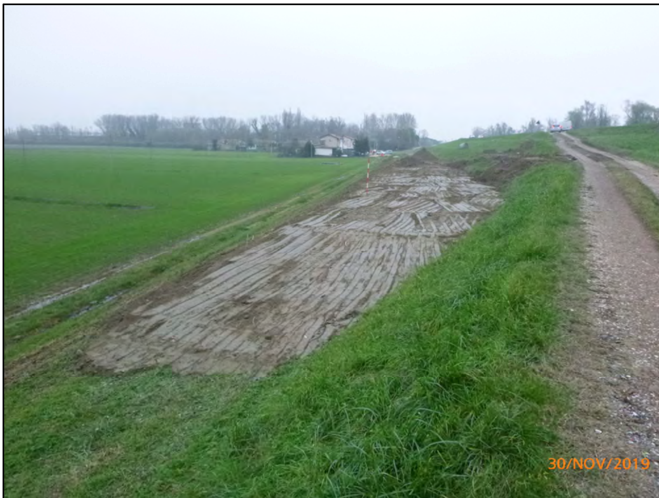
Fig. 12: località Cavanella Po - Rinfianco con posa di terra lungo un tratto del piè di banca arginale con problemi di saturazione (29.11.2019)
